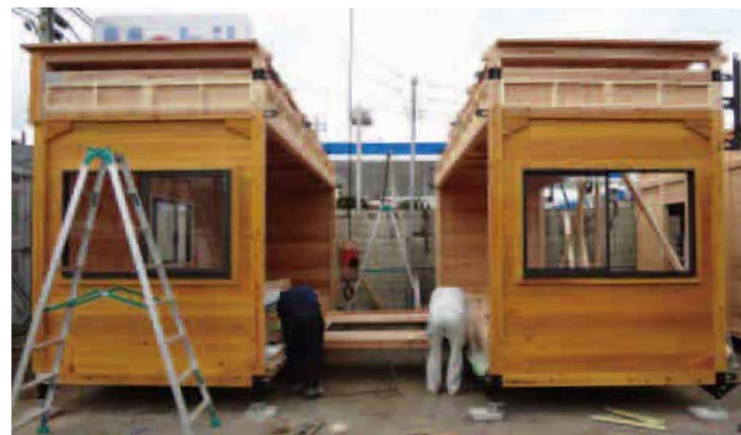
連棟組立の様子
