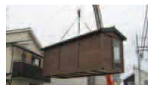
クレーンで吊上げて
