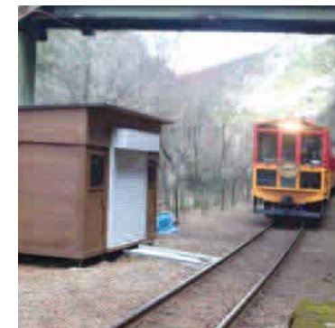
京都市 ログBOX 特注サイズ トロッコ保津峡駅 保線車両倉庫
